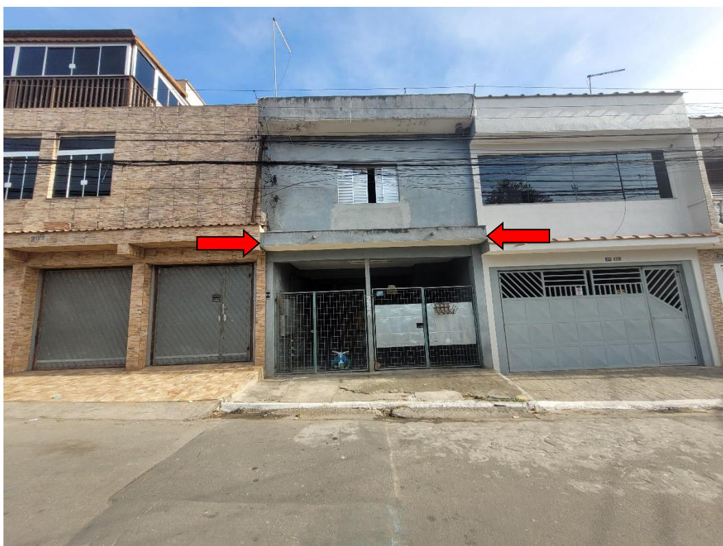
Foto 04: Frente do imóvel avaliando visto da Rua Solonopole, n.º 217 (atual), antigo nº 22A, Parque Uirapuru, entre as setas.
