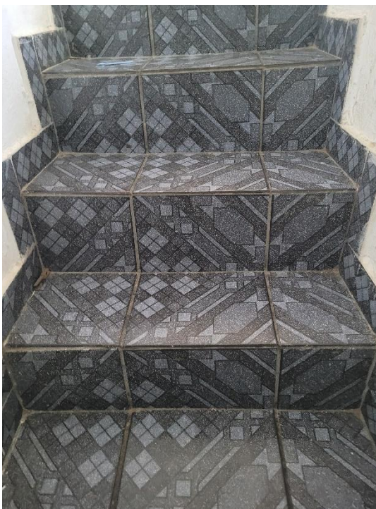
Foto 12: Escada com piso cerâmico e paredes revestidas com pintura.
