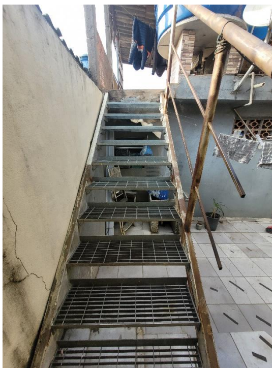
Foto 21: Escada em aço e parede revestida com pintura.
