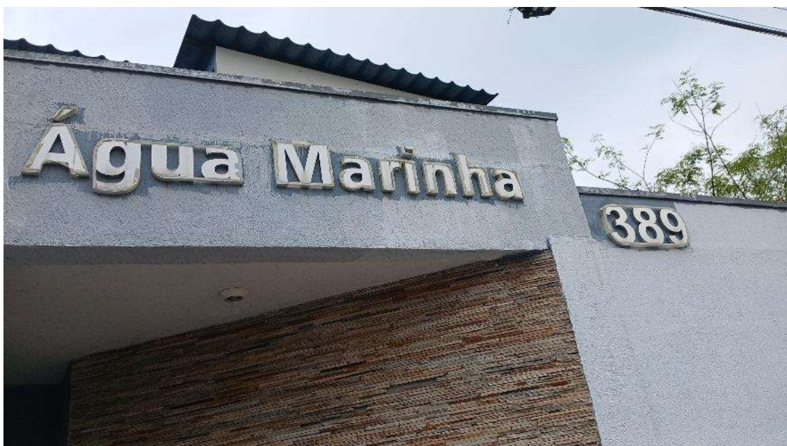
Objeto Pericial – Fachada do Condomínio Residencial Água Marinha.
