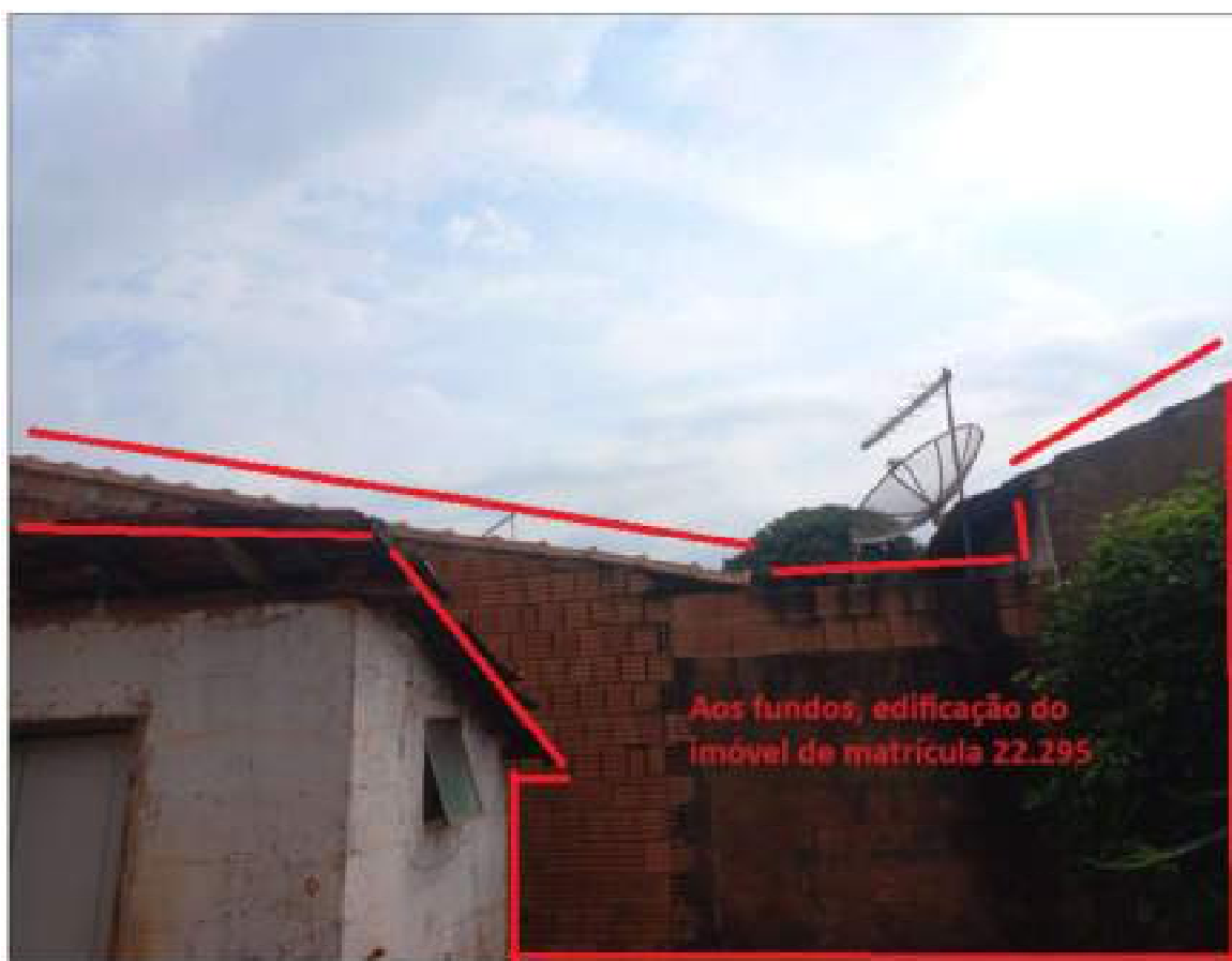
Foto 18: Parte da edificação dos fundos do imóvel 22.295
