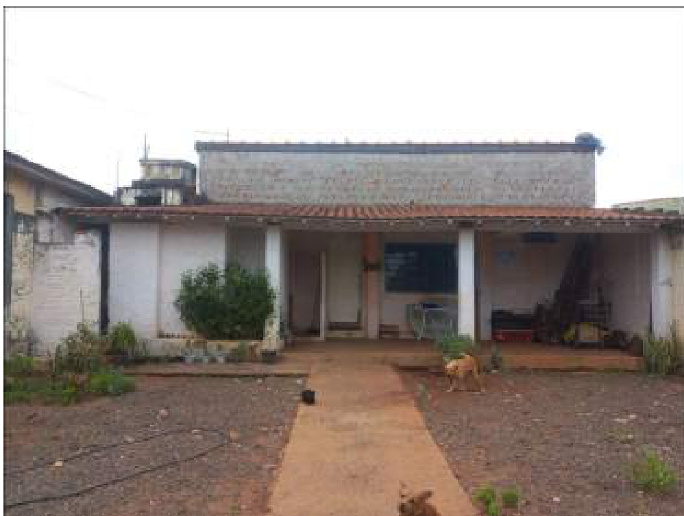
Foto 17: Fachada sem gradil do imóvel 22.295
