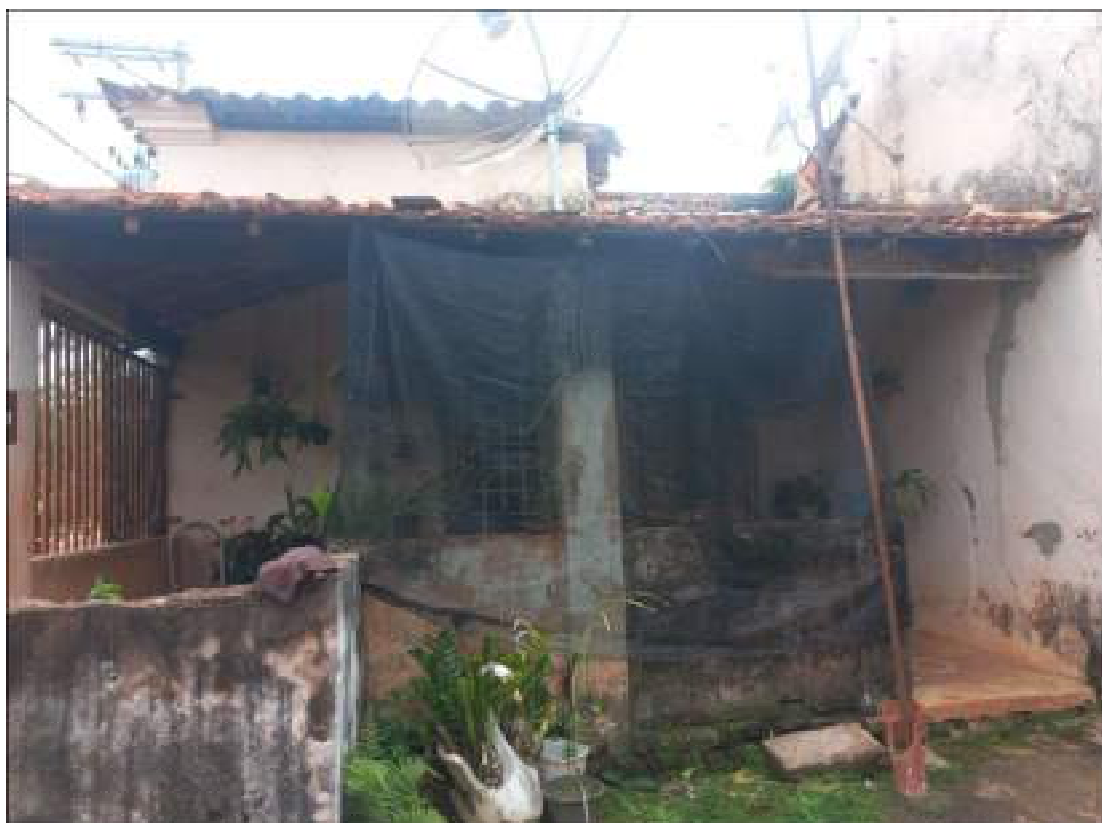
Foto 5: Varanda imóvel de matrícula 14.142
